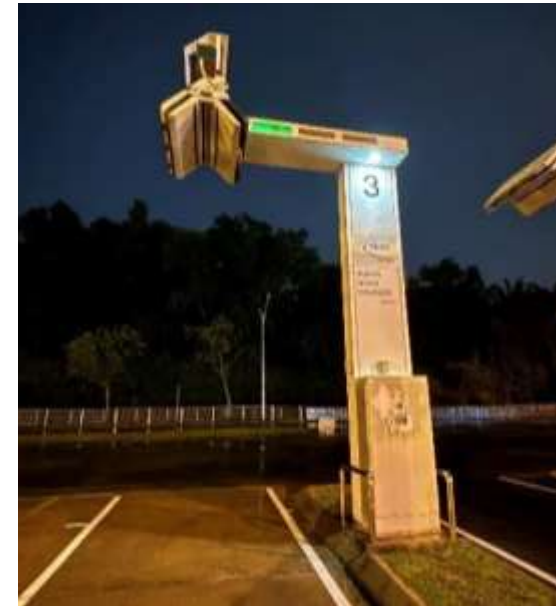
NEDOにより設置されたバス用 CHAdeMOパンタグラフは健在。 23:00ごろ充電開始。人工行政都市 プトラジャヤの駅前にて
